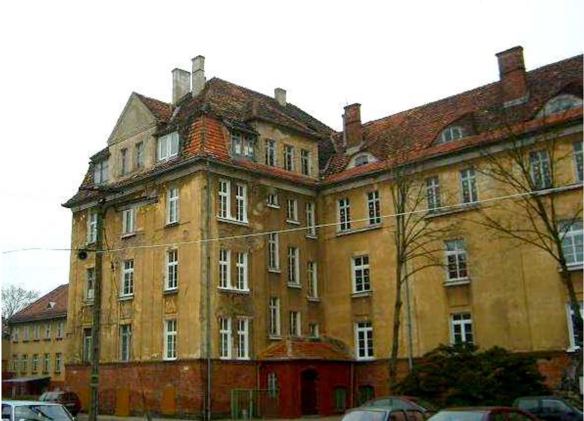
Widok segmentu lewego i środkowego od boiska
