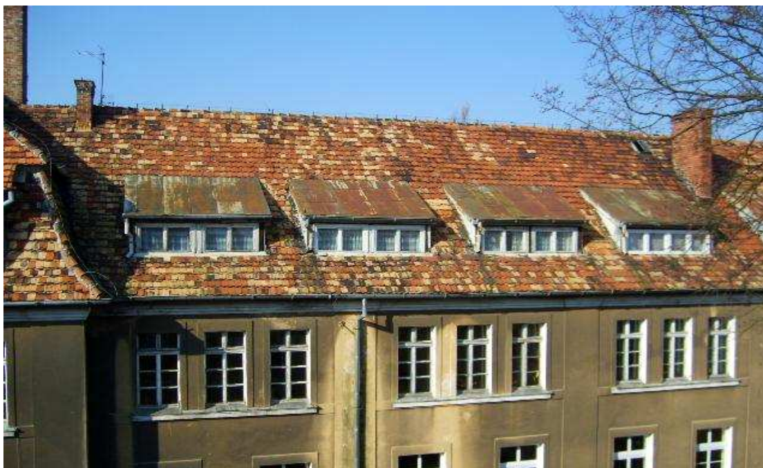
Fragment dachu z mansardami od ul Portowej
